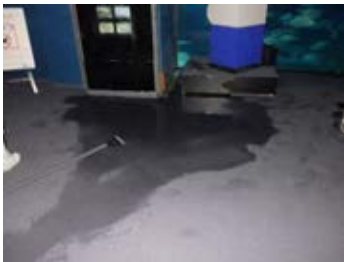
観覧面漏水発生！
