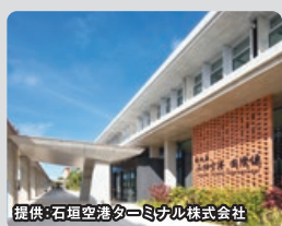
石垣空港 国内線・国際線
